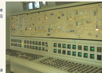
Pannello di controllo del termovalorizzatore
