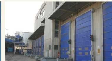
Portoni di accesso scarico in fossa
