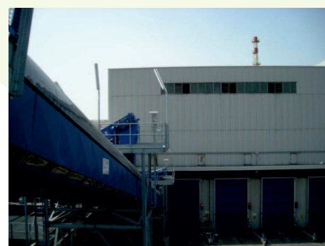
Portoni di ingresso alle fosse della linea CDR1
