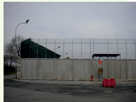
Barriere di contenimento del rifiuto alla Stazione di Travaso
