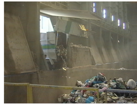
Fossa di scarico rifiuti
